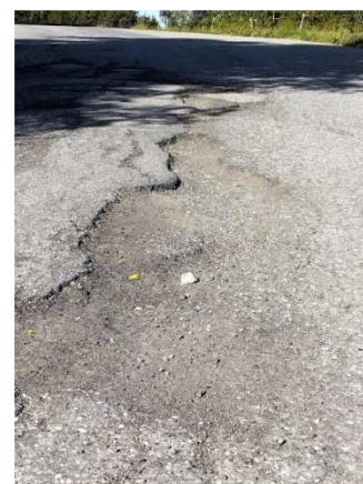
Route de la vallée des plein Bauches été 2023 8-10cm d'écart de bitume Secteur dangereux
